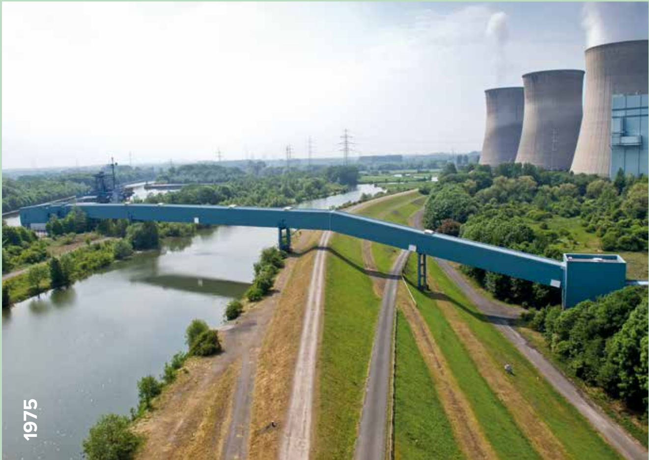
Der 1937 in Hamm-Herringen errichtete Lippe-Deich wird aufgrund bergbau-licher Einwirkungen erhöht. Heute ist er mit inzwischen 17,47 Metern Höhe einer der höchsten Flussdeiche in Europa.
