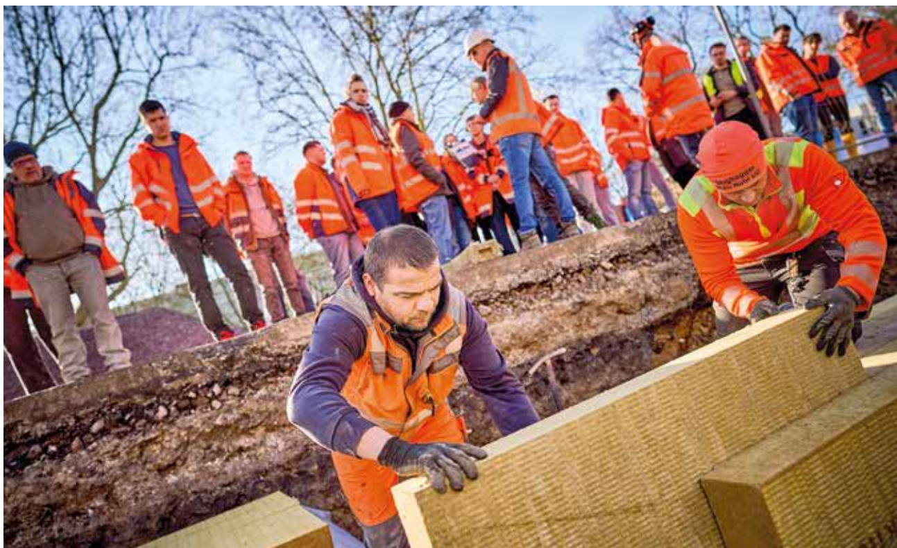
Auf der Baustelle an der Alleestraße: Die Steinwolle-Elemente zur Speicherung des Regenwassers wurden Anfang dieses Jahres eingebaut.
