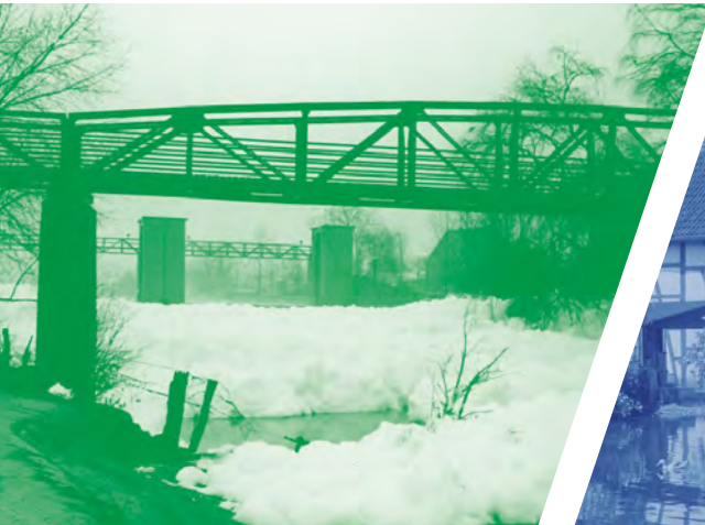
Schaumberge am Wehr in Lünen-Beckinghausen 1964, die Folge unzureichender Abwasserreinigung
