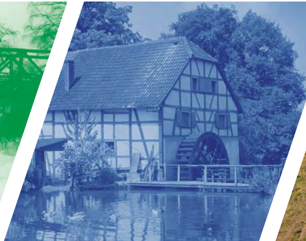
Mühle am Schölsbach: frühe Nutzung der Wasserkraft
