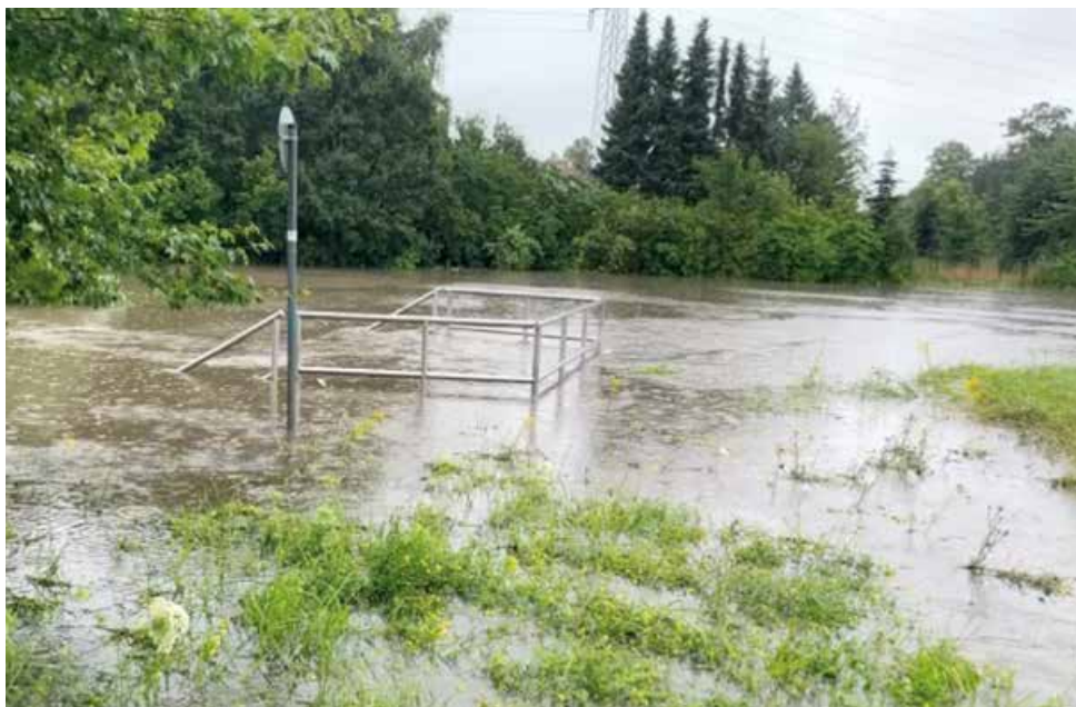
Beim Hochwasser im Juli 2021 wurde der Deich des Kuhbaches in Bergkamen überströmt.
