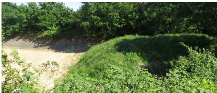
Damm ehem. Klärschlammbecken ©Stadt Haltern am See
