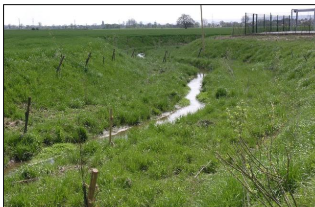
Anlage einer Sekundäraue innerhalb intensiv genutzter landwirtschaftlicher Flächen durch Profilaufweitung auf Mittelwasserniveau (U. Koenzen)
