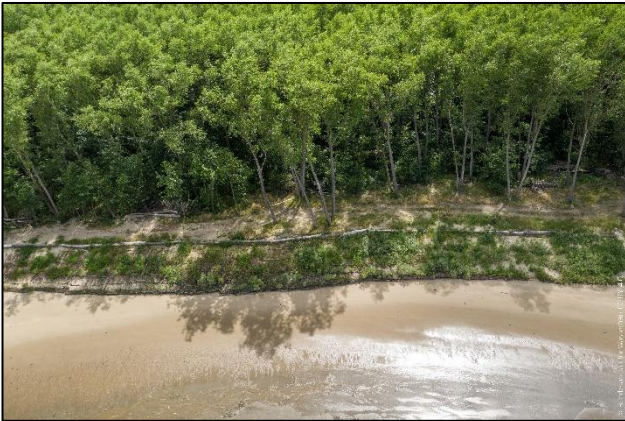
Weidenspreitlagen als Ufersicherung an einem sandgeprägten Strom. (BAW, CC BY 2.0)
