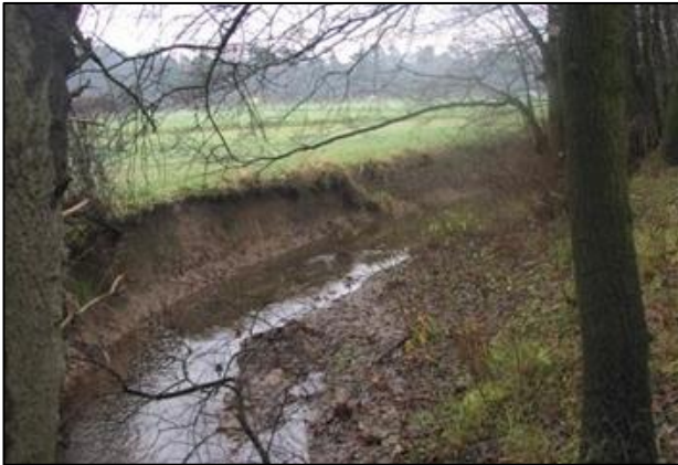
Uferabbrüche nach Entfernung des Uferverbau. (U. Koenzen)
