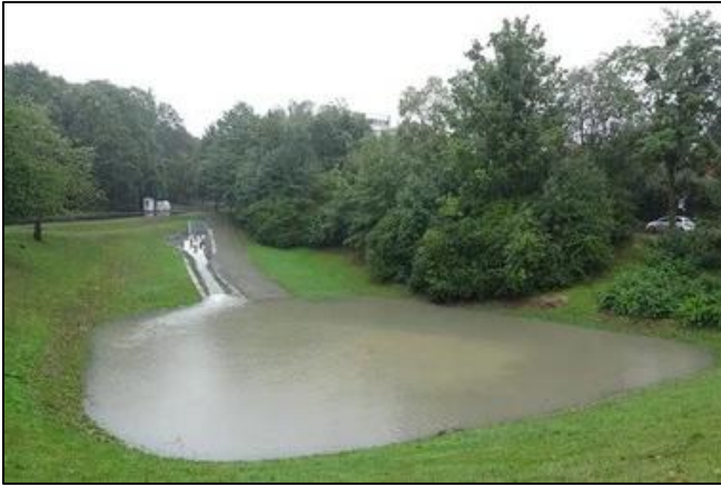
Regenrückhaltebecken in Erdbauweise mit Einlaufbauwerk im Lastfall (J. Engelhardt, CC0 1.0 Universal ).
