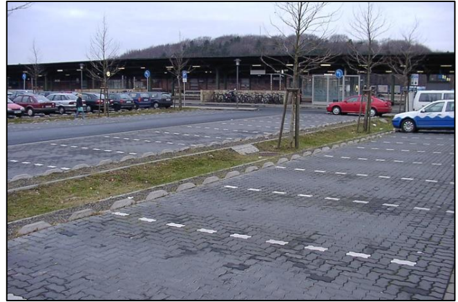
Versickerungsgraben auf einem Parkplatz (CLZ, CC BY-SA 4.0)
