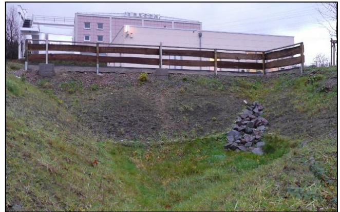
Versickerungsbecken auf Firmengelände (Raenman, CC BY 3.0)
