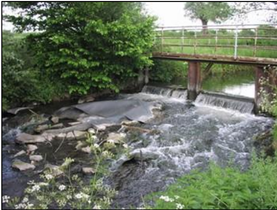
Ehemaliges Kulturstauwehr, das durch eine flache Gleite – unter Verkleinerung des Rückstaus – ersetzt wurde (links) (© PBK)
