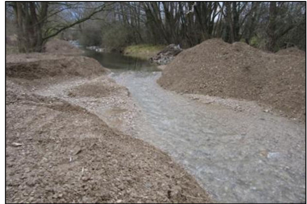
Sohlanhebung durch Geschiebezugabe in einem Mittelgebirgsfluss (© PBK)
