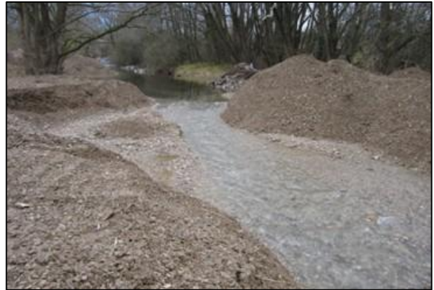
Geschiebedepot an einem schotterprägten nach der Einbringung (© PBK)
