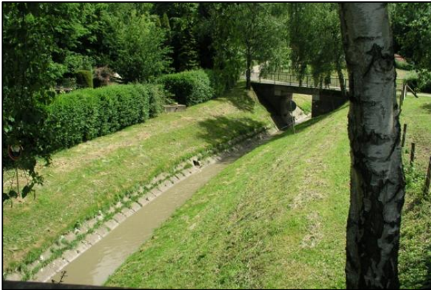
Massiver Sohlverbau mit Betonschalen (© PBK)
