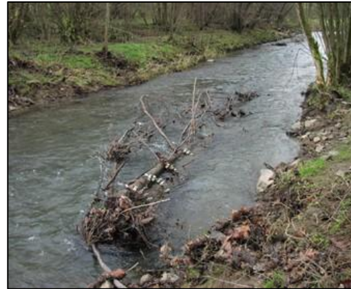
Totholz-Einbau zur Sicherung der Sohle, hier ohne Möglichkeit der seitlichen Verlagerung des Gewässers (Foto: A. Kurth)
