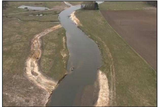
Anlage eines Nebengerinnes an einem Tieflandfluss zur weiteren eigendynamischen Entwicklung. (© PBK)
