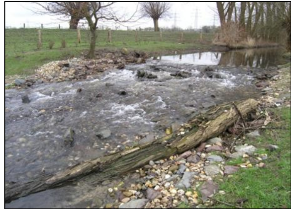
Ehemaliges Kulturstauwehr (rechts), das durch eine flache Gleite – unter Verkleinerung des Rückstaus – ersetzt wurde (© PBK)
