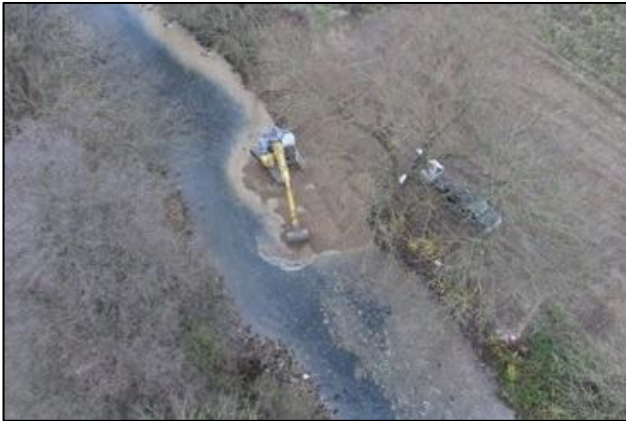
Geschiebezugabe an einem schotterprägten Fluss während der Bauphase (© PBK)
