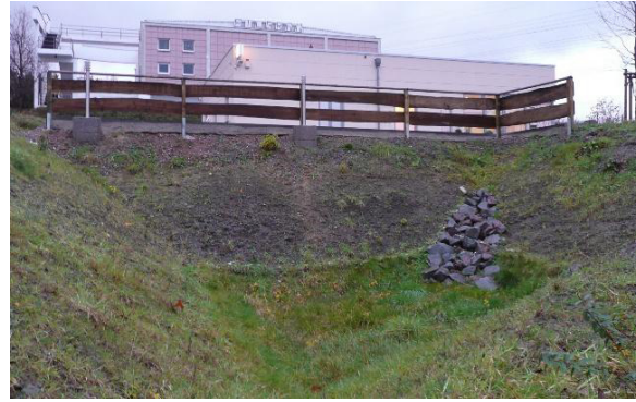
Versickerungsbecken auf Firmengelände (Raenman, CC BY 3.0)
