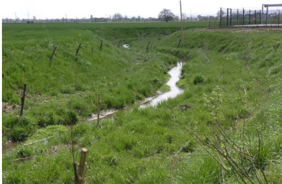
Anlage einer Sekundäraue innerhalb intensiv genutzter landwirtschaftlicher Flächen durch Profilaufweitung auf Mittelwasserniveau (Foto: U. Koenzen)
