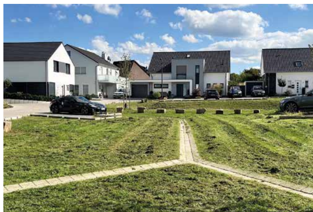
Offene Rinnen für Regenwasser-Ableitung
