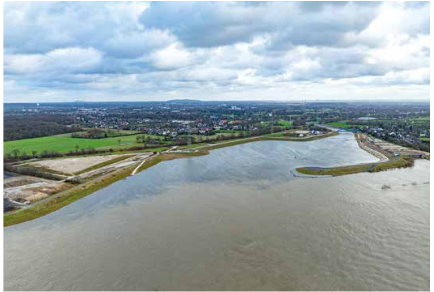
Auch die Emscher führte über Weihnachten und Neujahr Hochwasser. Die Wassermassen konnten schadlos durch das neugestaltete Mündungsdelta in Richtung Rhein transportiert werden.
