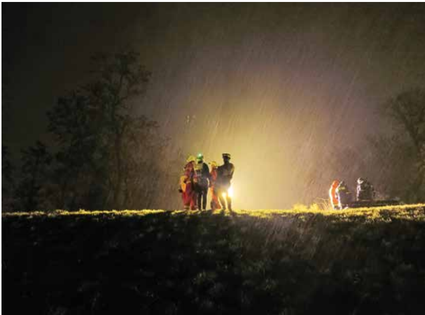
Einen intensiven Einsatz erlebten zahlreiche Einsatzkräfte Weihnachten 2023 in Oberhausen-Alstaden. Dort musste der Ruhr-Deich nach starken Regenfällen auf einer Strecke von 500 Metern gesichert werden.
