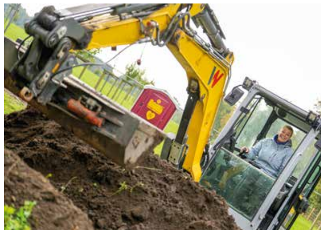
Sichtlich Freude hatten die Auszubildenden beim Ausführen kleinerer Baggerarbeiten.
