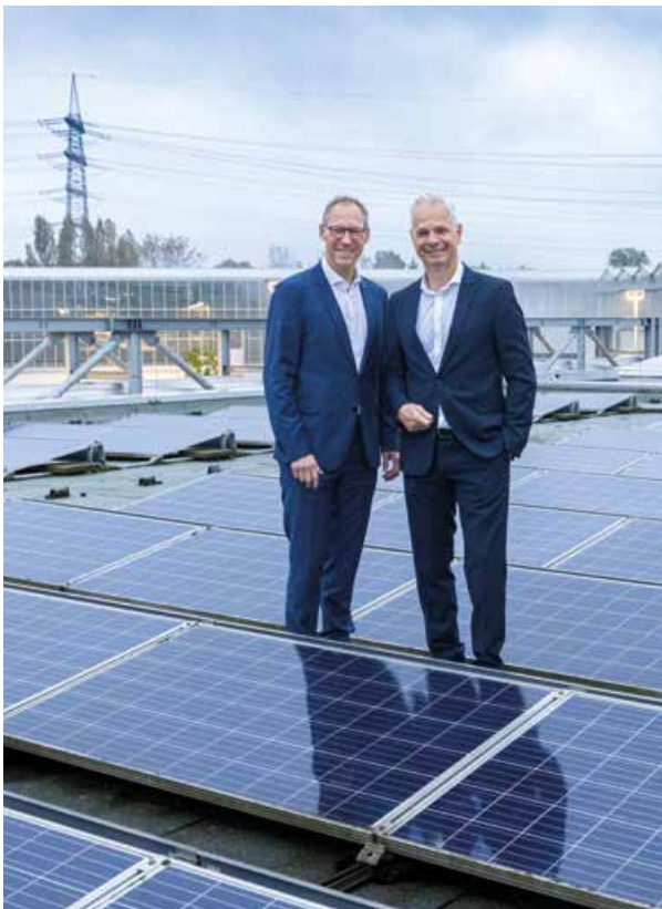
Prof. Dr. Torsten Frehmann und Technik-Vorstand Dr. Frank Obenaus bei der Photovoltaik-Anlage der Kläranlage Bottrop
