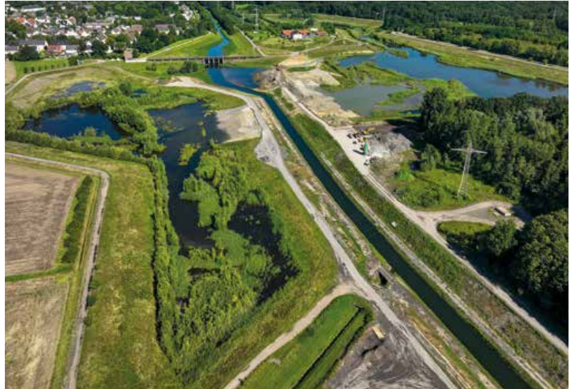
Das Hochwasserrückhaltebecken Emscher-Auen an der Stadtgrenze Dortmund/Castrop-Rauxel.
