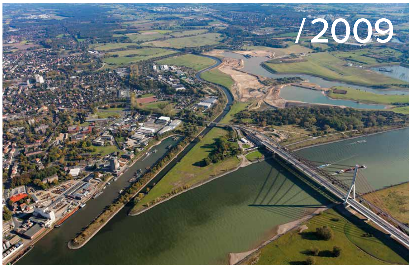
Im Jahr 2009 haben die Arbeiten zum Umbau der Lippe-Mündung begonnen.
