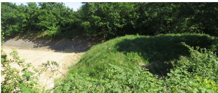
Damm ehem. Klärschlammbecken ©Stadt Haltern am See
