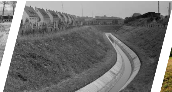
Offene Schmutzwasserläufe mit Betonkorsett.
