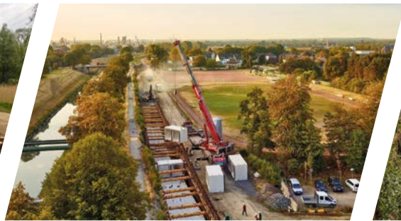
Verlegung des Abwasserkanals Emscher in Oberhausen.
