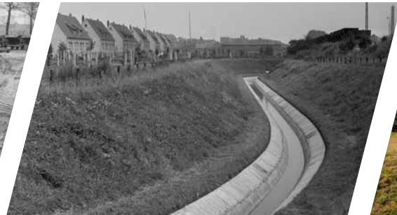
Offene Schmutzwasserläufe mit Betonkorsett
