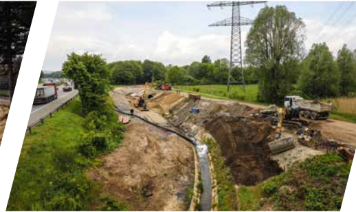
Boye-Renaturierung nördlich der A2, Bottrop/ Gladbeck
