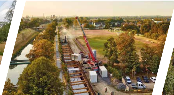
Verlegung des Abwasserkanals Emscher in Oberhausen
