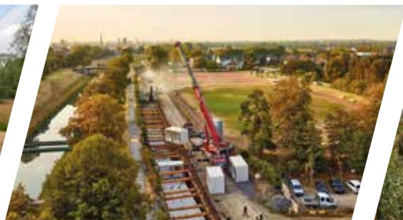
Laying the Emscher Sewer in Oberhausen
