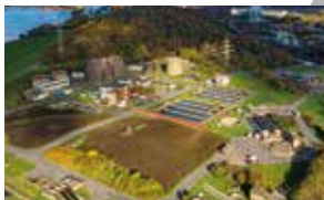
16 Kläranlage Alte Emscher
