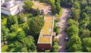
02 Gemeinschaftsmüll- verbrennungsanlage Niederrhein GMVA und Energiever- sorgung Oberhausen
