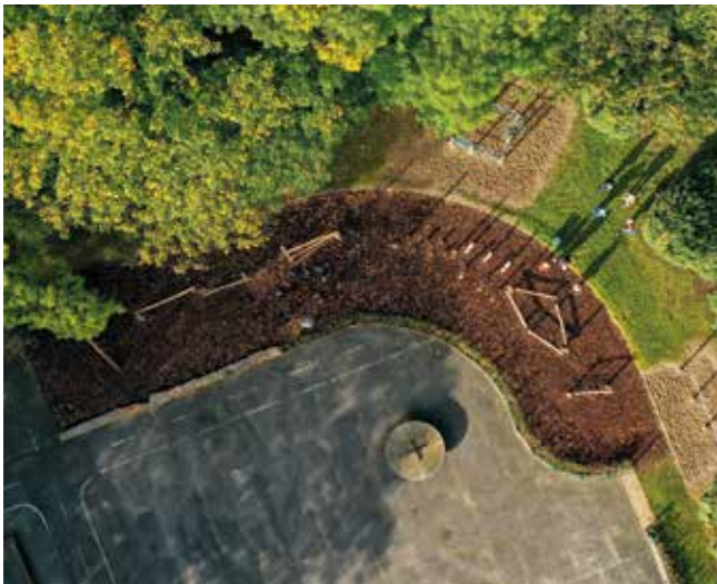
Erste Projekte der Klimafolgenanpassung wurden bereits umgesetzt – wie die Dachbegrünung auf einer Müllverbrennungsanlage in Oberhausen (oben) oder die Teil-Entsiegelung auf dem Schulhof einer Grundschule in Mülheim.
