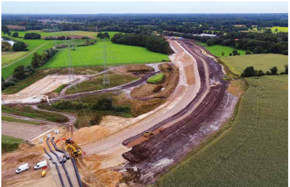
Oelder Weg; Blick Richtung Westen zum Hof Belustedde: Links sieht man noch knapp die Lippe und den Altdeich (inkl. Deichkronenweg) und rechts den neuen Deich, der auf der Landseite bereits komplett fertig ist. Eine Raupe baut aktuell den dortigen Deichkronenweg auf. Druckrohrleitungen werden über den Deich verlegt, aber so, dass sie mit Material angeschüttet werden und Radfahrende mit einer leichten Steigung rüberfahren können. Die Starkstrommasten bleiben in den neuen Auen stehen – sie sind Hochwassersicher gebaut.
