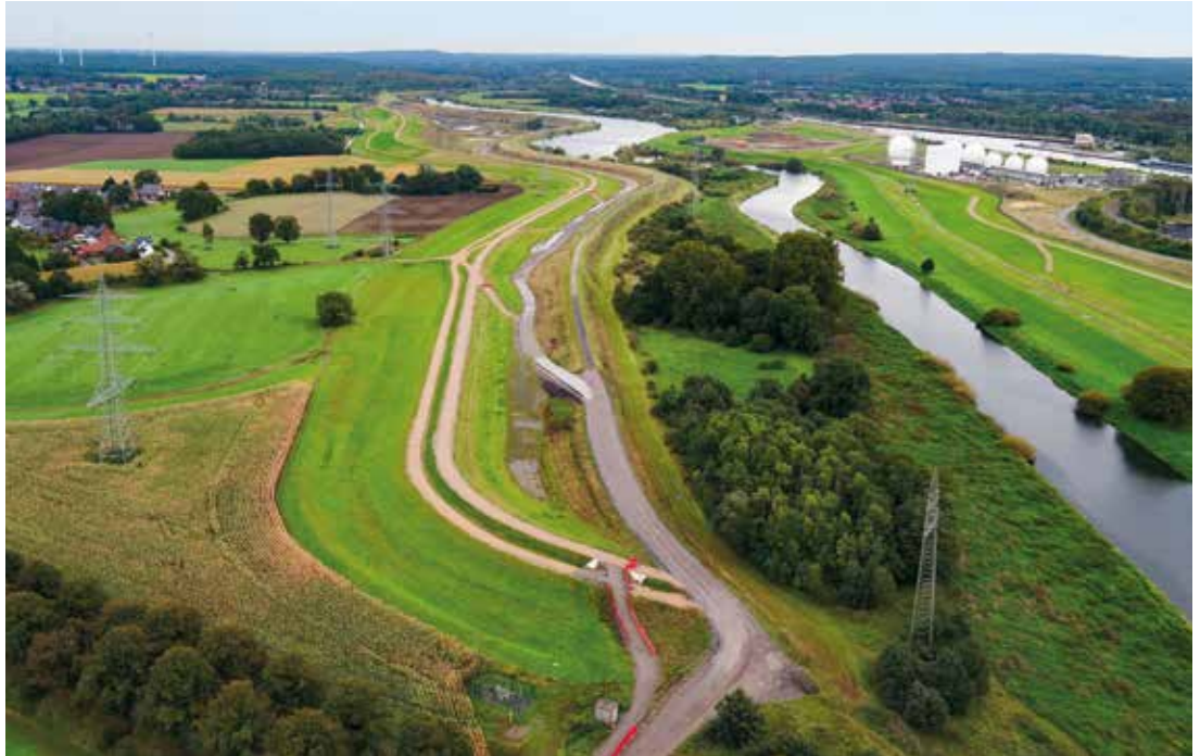
Blick auf den neuen Deich (links) und den alten Deich direkt rechts daneben im Bauabschnitt Nord 1. Hier kann der Lippe aus Gründen des Hochwasserschutzes nicht viel mehr Raum gegeben werden. Blickt man weiter nach hinten, erkennt man, dass dort der neue Deich weiter von der Lippe entfernt steht und später in dem Bereich eine schöne Auenfläche entstehen kann.
