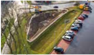
01 Kreuzung Hünxer-/ Gerhard-Malina- Straße
