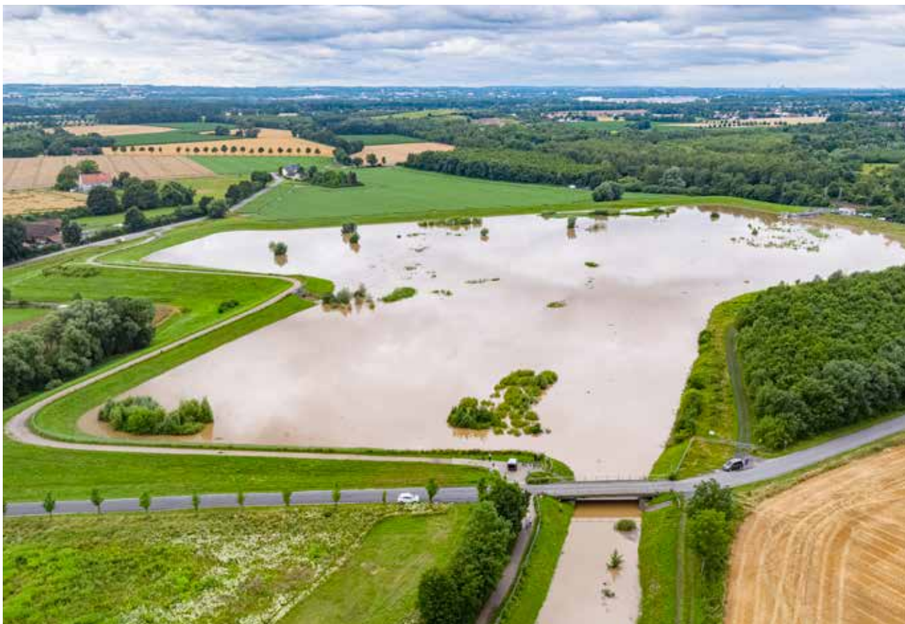
Das Hochwasserrückhaltenbecken in Bönen war am 15. Juli auf Grund der Hochwasserlage komplett eingestaut.
