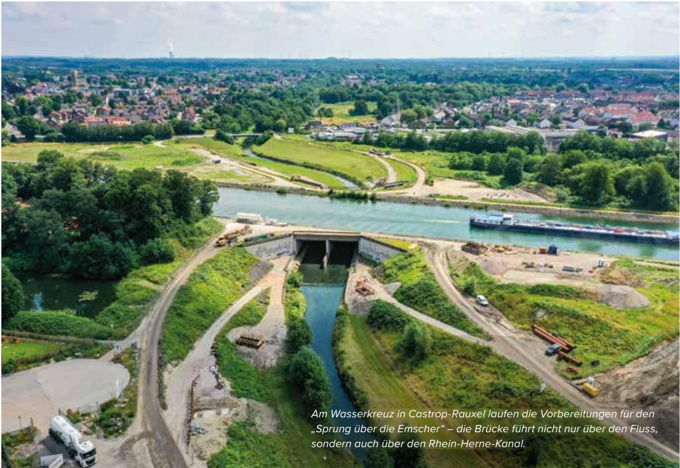
*Am Wasserkreuz in Castrop-Rauxel laufen die Vorbereitungen für den „Sprung über die Emscher“ – die Brücke führt nicht nur über den Fluss, sondern auch über den Rhein-Herne-Kanal.*
