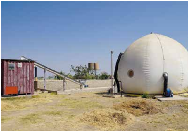
Die Elektroräume auf den Kläranlagen sind in Containern untergebracht.
