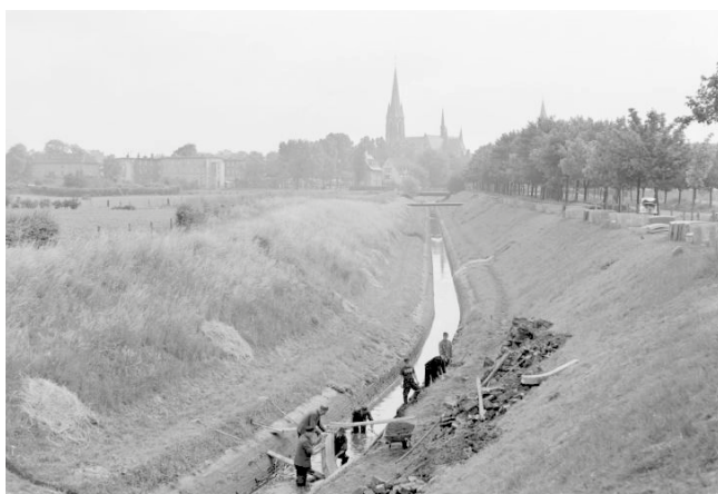
Bis 2010 war die Seseke ein geradliniger, mit Betonschalen technisch ausgebauter Fluss. Heute ist sie ein abwechslungsreiches, naturnahes Gewässer.
