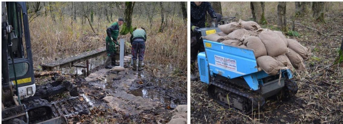
Von Hand und mit einem besonders bodenschonenden Materialtransport durch das Moor (das blaue Kettenfahrzeug) konnten so die Dämme erstellt werden.
