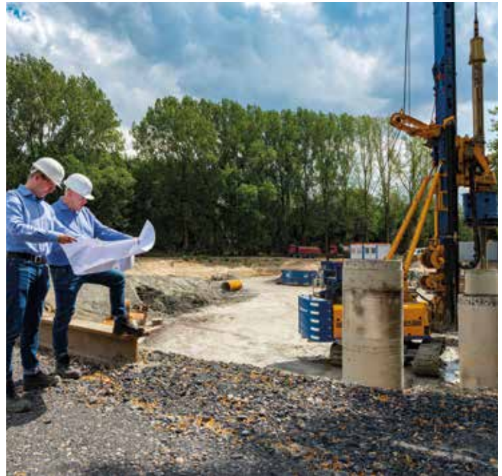
Projektleiter vor Ort: Jens Lukas und Andreas Gießler auf der Holzbach-Baustelle
