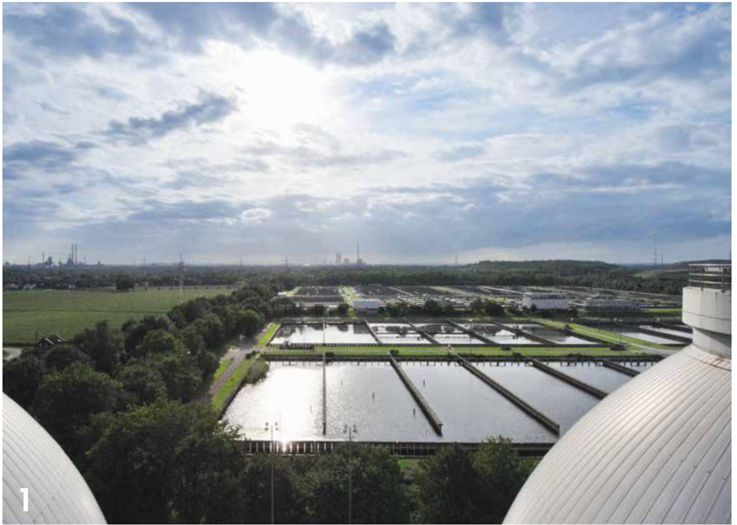
1. So sah die Anlage 2013 aus – deutlich zu erkennen sind vorne die alten Vorklärbecken. Foto Ilias Abawi
