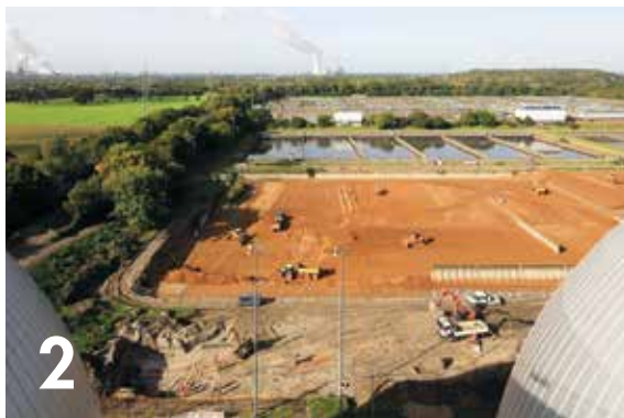
2. Kurz nach Start des Umbaus 2014. Die Vorklärbecken sind mittlerweile verfüllt worden, hier entsteht nun die neue mechanische Reinigung.
