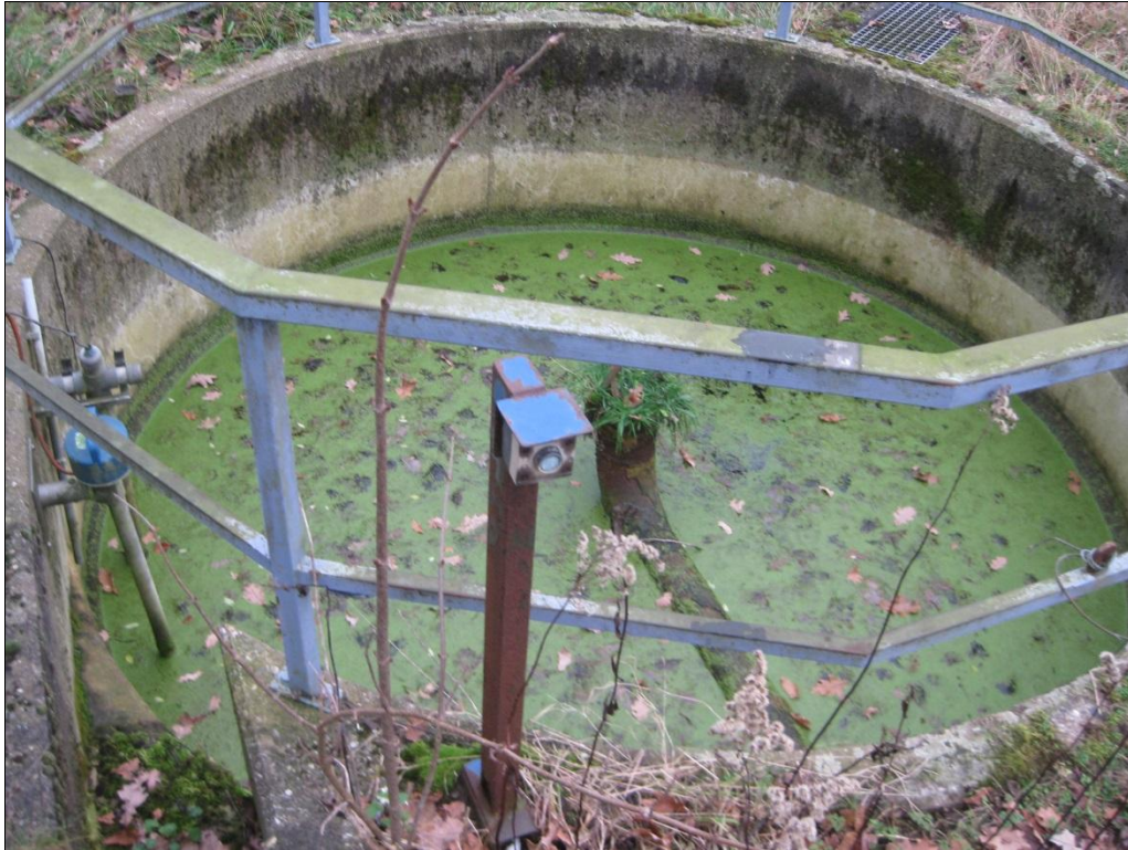
Abbildung 11: Schwimmstofffang
