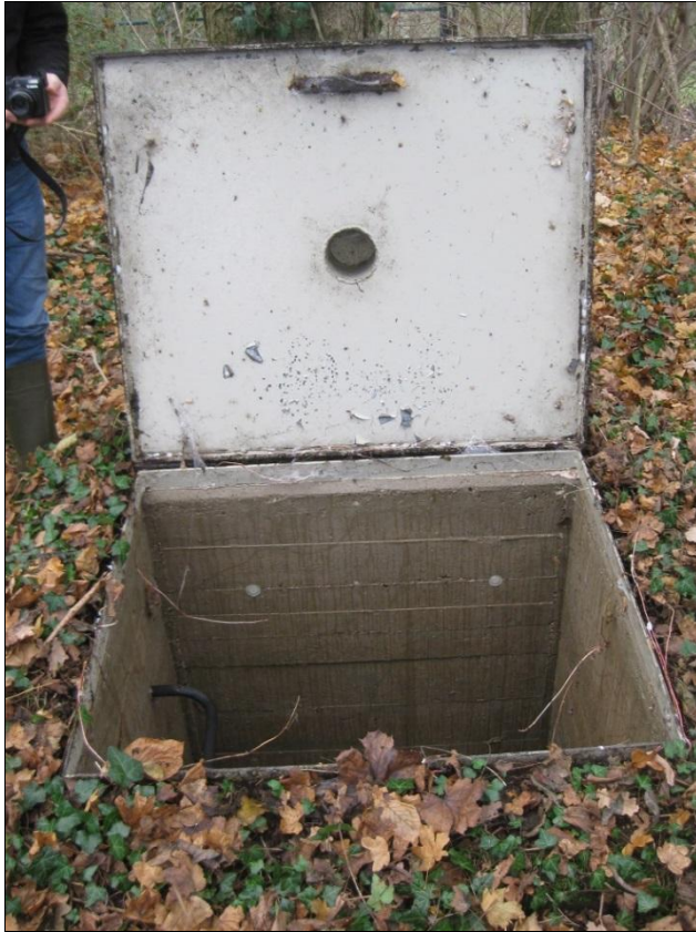
Abbildung 22: Schacht des Kläranlagen-Ablaufes zur Lippe
