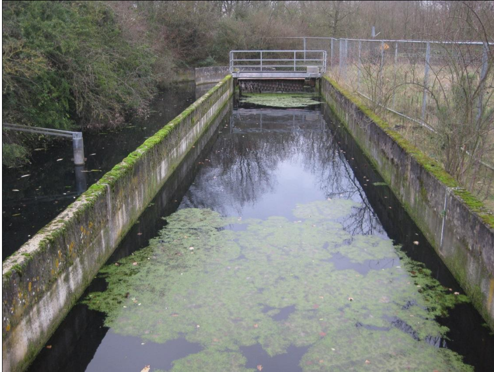
Abbildung 13: Oxidationsbecken
