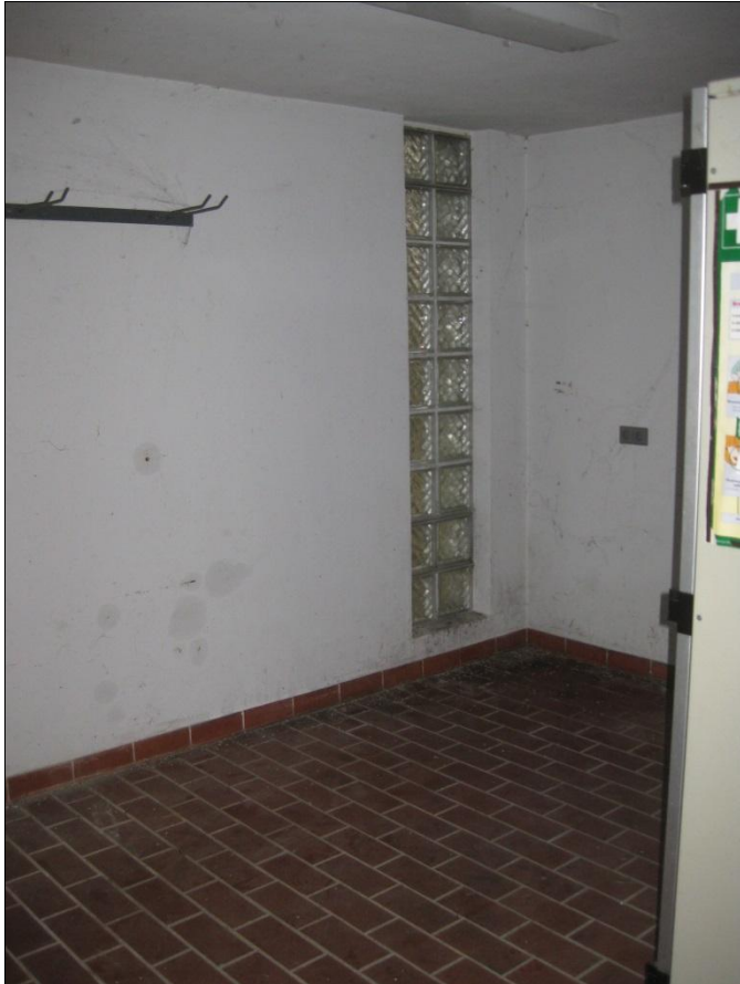
Abbildung 8: Innenansicht großer Raum Betriebshaus
