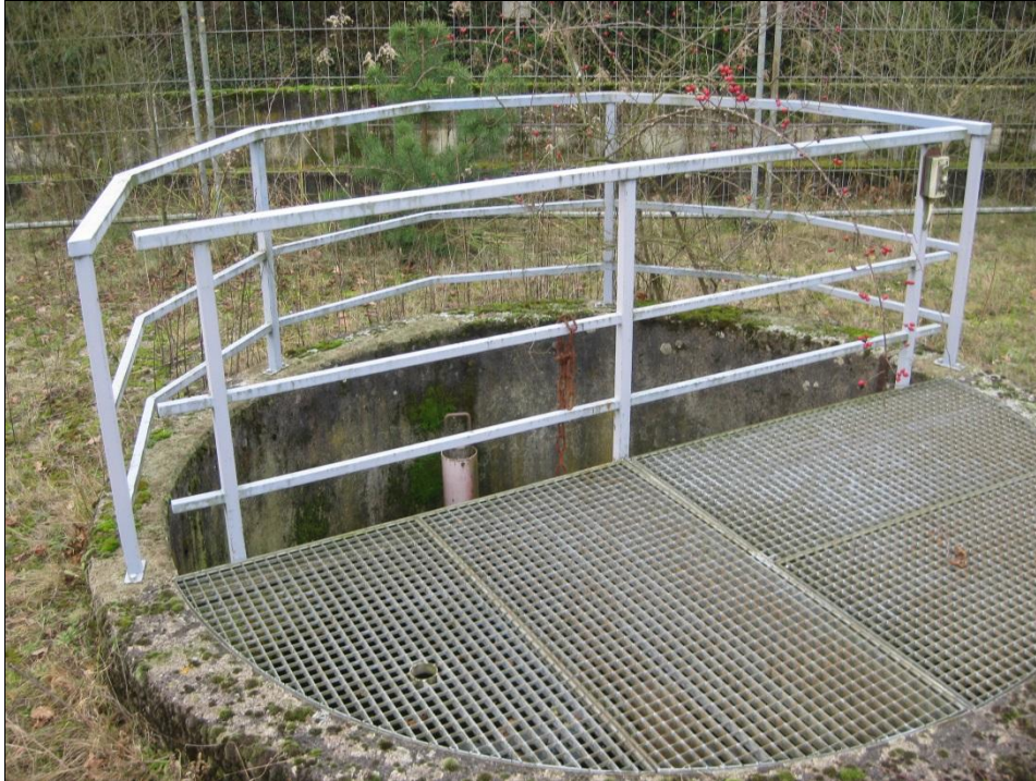
Abbildung 18: Schlammfang
