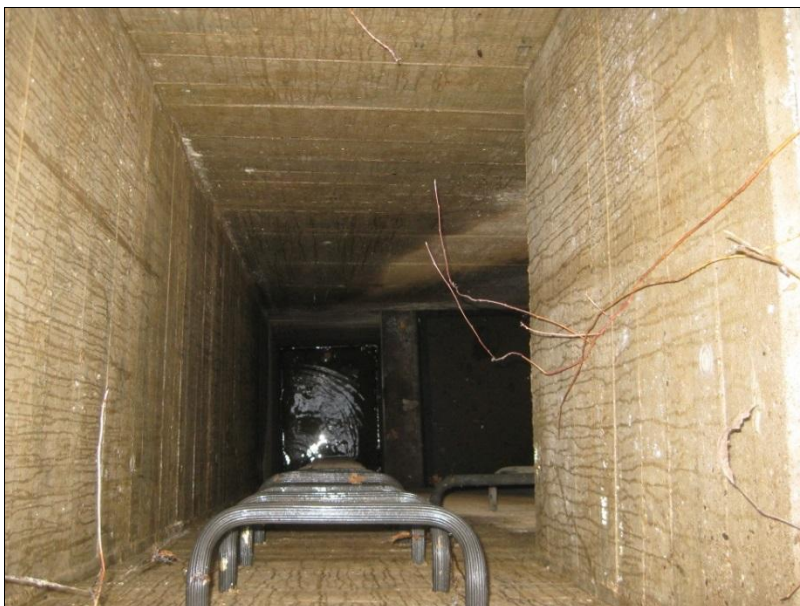
Abbildung 23: Ablaufschacht zur Lippe
