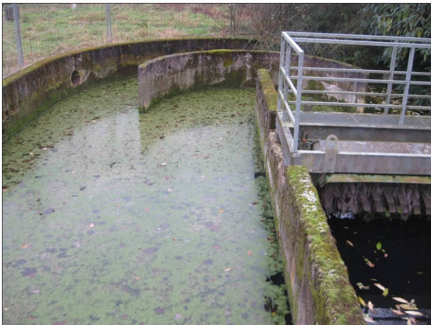
Abbildung 14: Oxidationsbecken, gerundete Stirnseite sowie Strömungsenker
