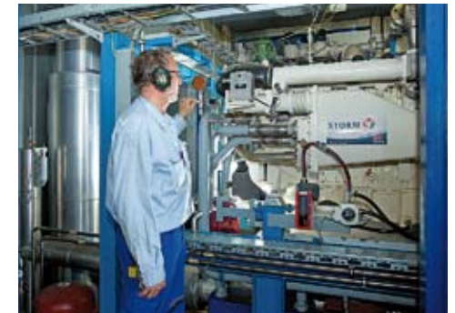
Blockheizkraftwerk auf der Kläranlage Hamm-Radbod. Foto: Rupert Oberhäuser
