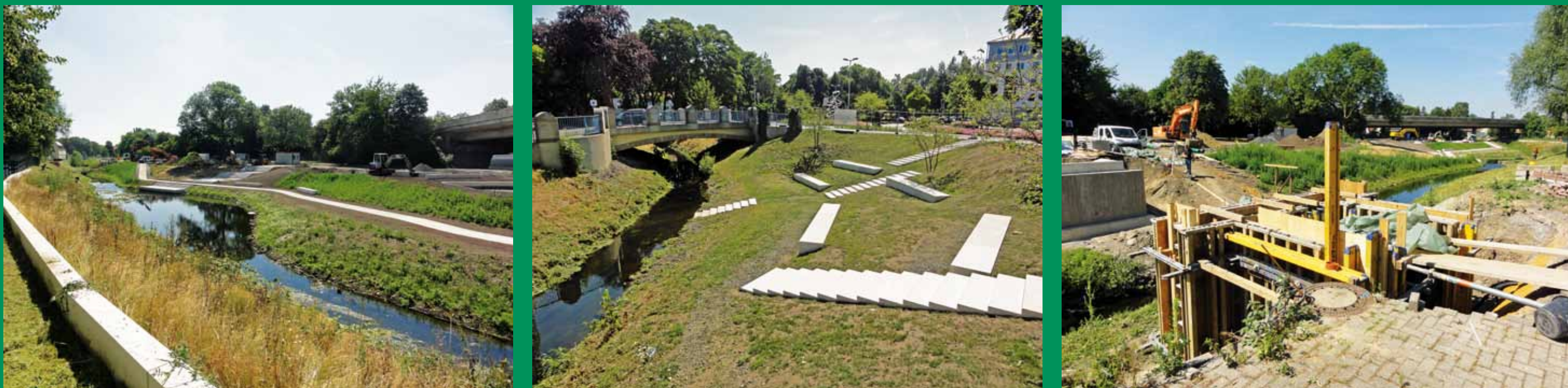
Seseketerrassen und Wandelweg (im Bau)
