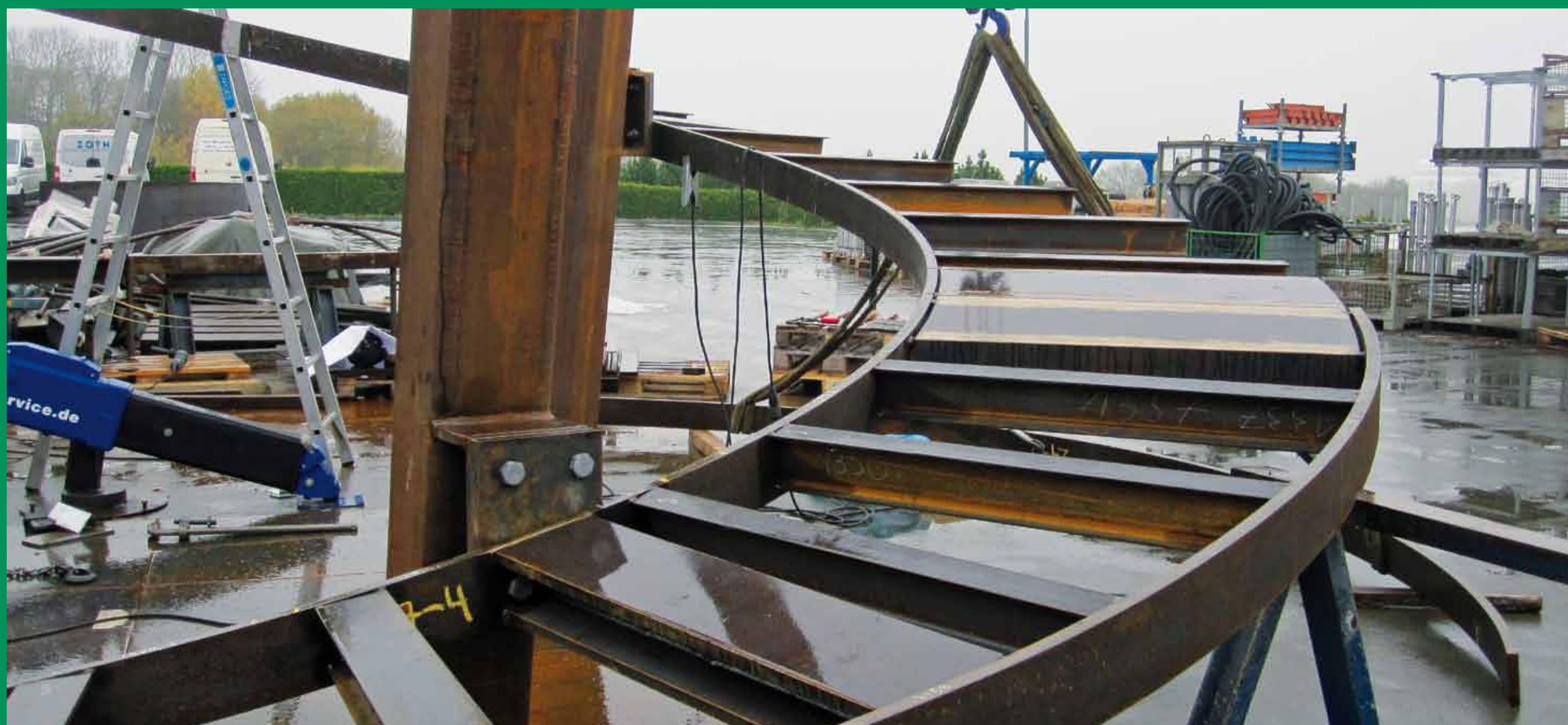
Bau des Haldenzeichens
