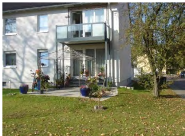
Abbildung 64: neuangelegte Terrasse und Versickerungsmulde, Bottrop-Welheim
