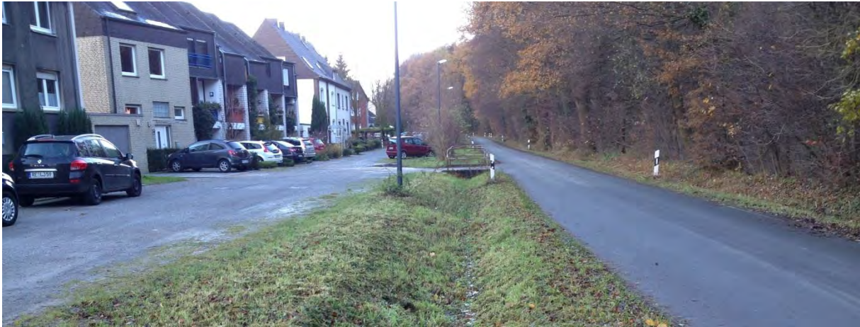
Abbildung 19: Grabenentwässerung Jägerstraße (eigene Abb.)
