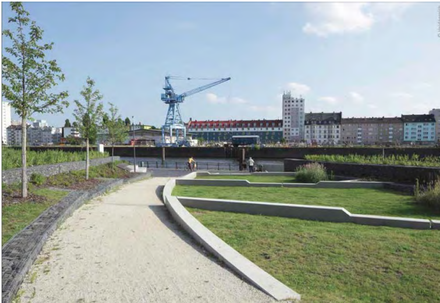
Abbildung 102: Retentionsbecken für das Regenwasser im Molenpark (Foto: Atelier Dreiseitl)
