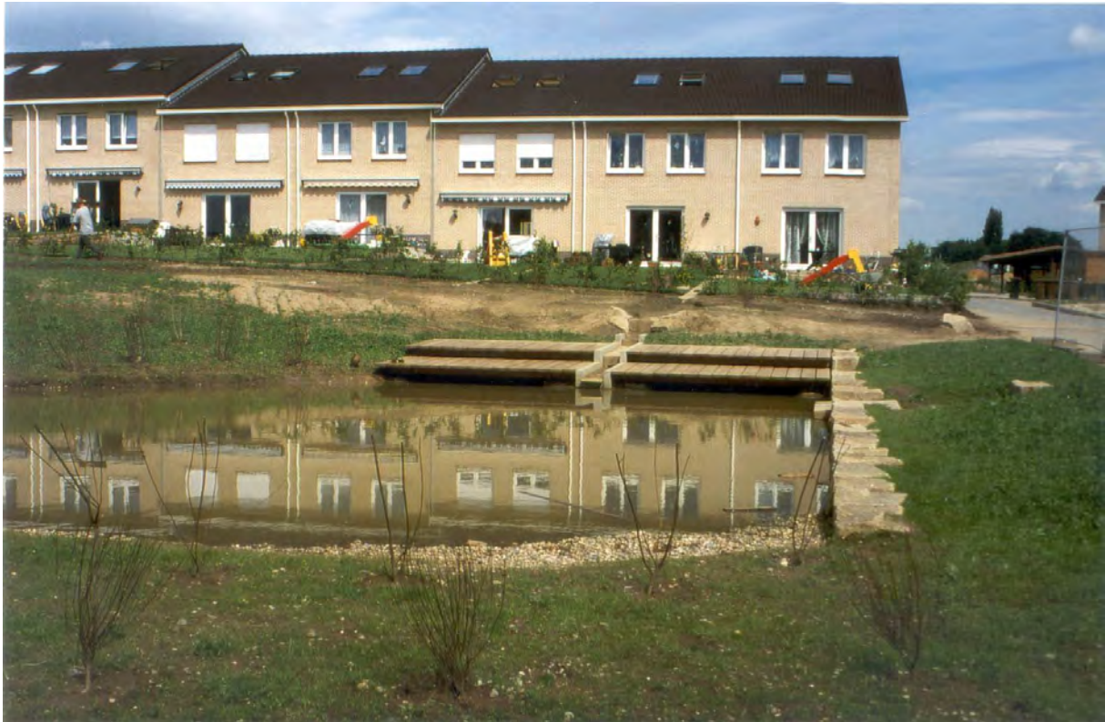
Abbildung 5: Wohngebiet Backumer Tal, dezentrale Regenwasserbewirtschaftung (Stadt Herten)
