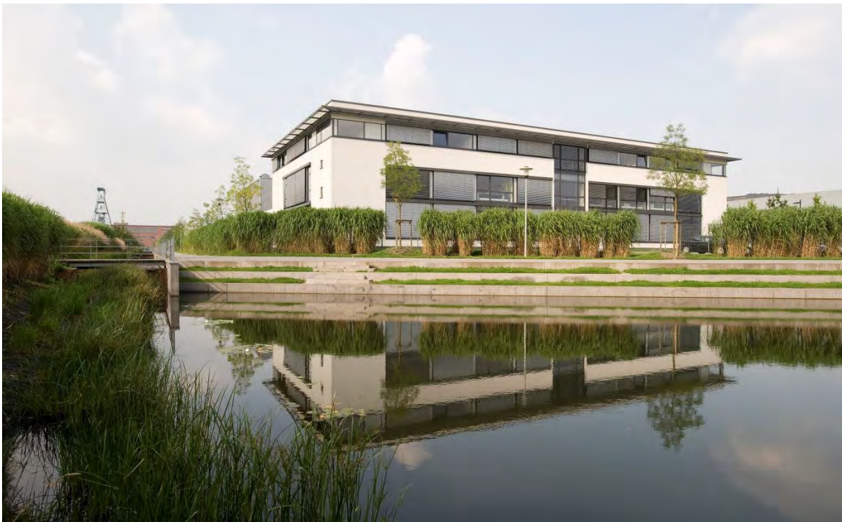
Abbildung 26: Einleitung der Dachabflüsse in das „Blaue Band“, Zeche Ewald (Stadt Herten)
