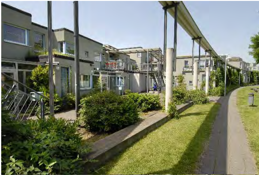
Abbildung 93: Blick entlang einer der aufgeständerten Regenwasserrinnen (Gelsenkirchen 2013)
