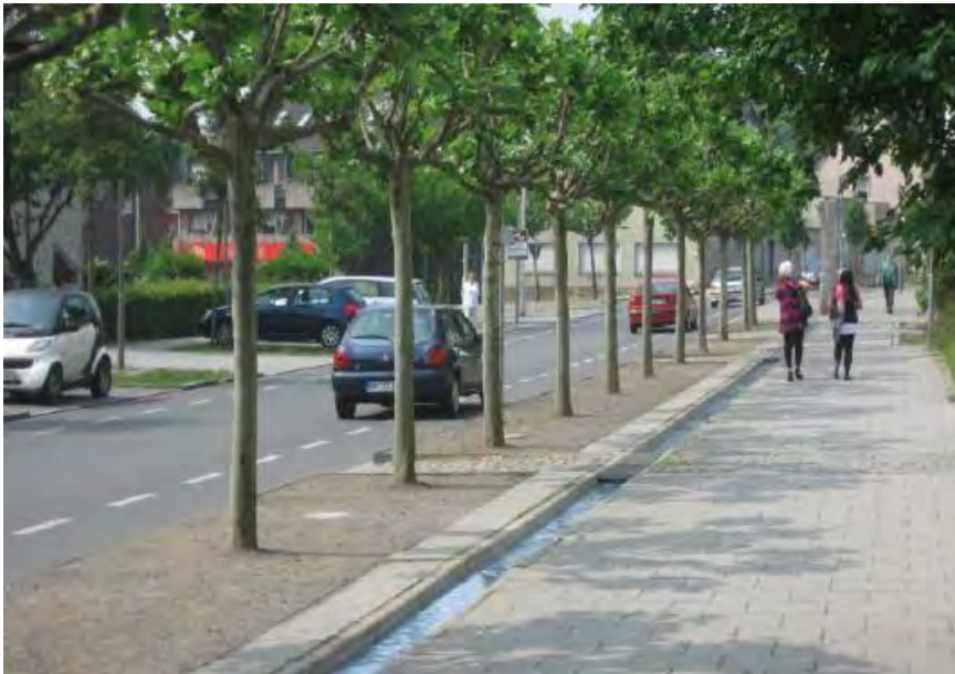
Abbildung 101: Die mit Regenwasser gespeiste blaue Rinne verläuft parallel zum Gehweg und gliedert den Stadtraum (Bergkamen 2013)
