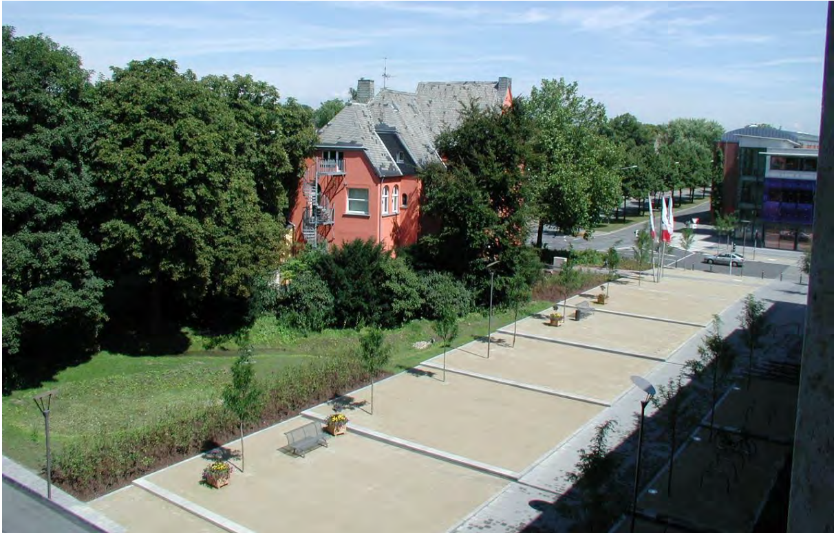
Abbildung 13: Dezentrale Regenwasserbewirtschaftung Rathausvorplatz und VHS Herten (Stadt Herten)
