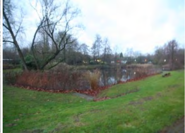
Abbildung 75: Zum Rückhaltebecken ausgebauter Teich mit Anschluss an den Backumer Bach.
